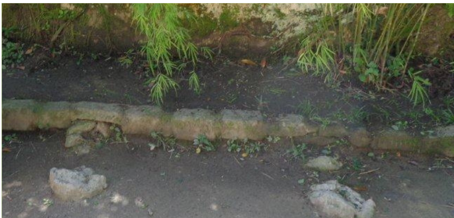
CANTEIRO MURO LATERAL ESQUERDA
