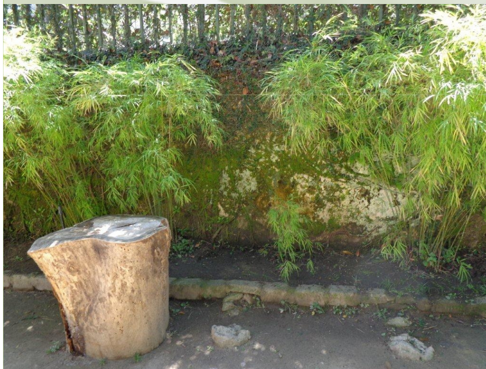
CANTEIRO MURO LATERAL ESQUERDA
