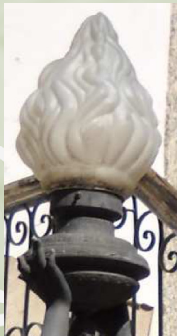
DETALHE DA LUMINÁRIA
